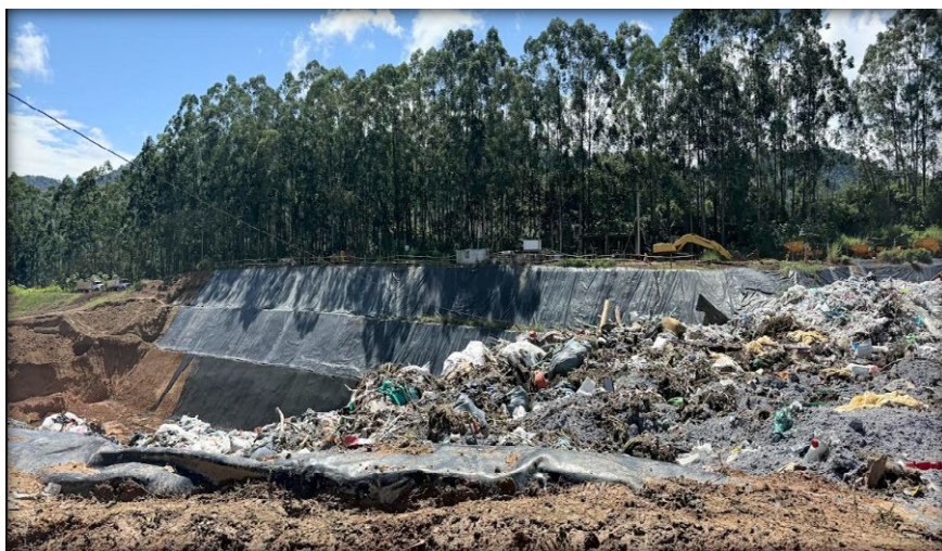
Figura 36. Vista general de la unificación de los vasos 8 y 9 del Relleno Sanitario La Glorita
