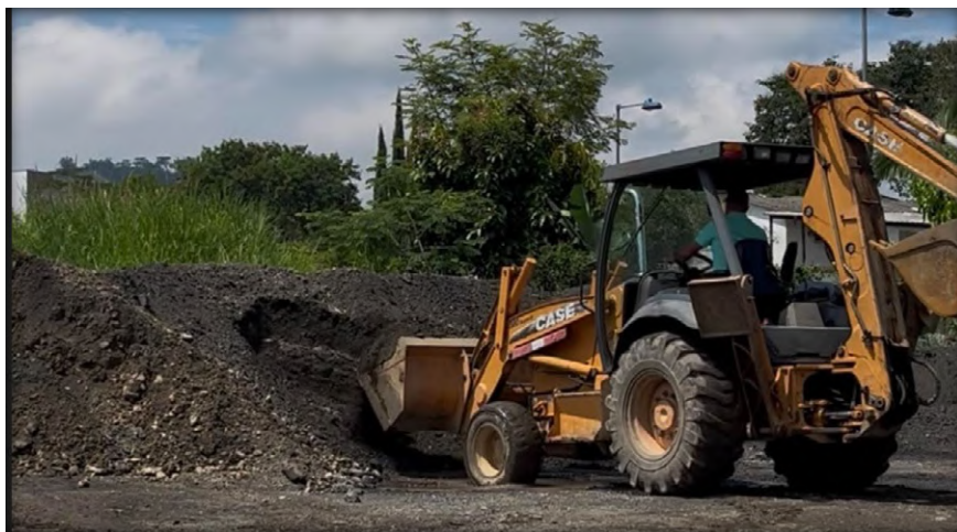
Figura 22. Material fresado para aprovechamiento en vías
