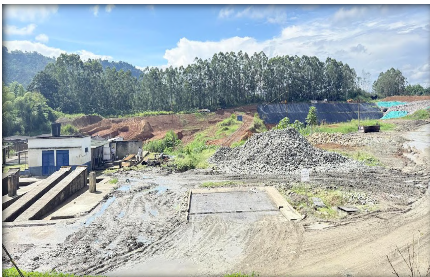
Figura 39. Zona de descarga de lixiviados de caja de vehículos Relleno Sanitario La Gloria
