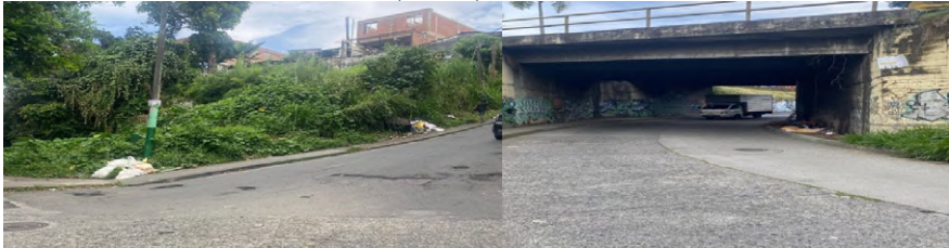
Punto crítico 4. Área inferior puente que comunica con el barrio los Cisnes
