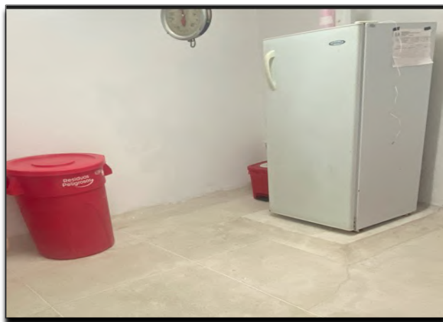
Figura 28. Área de almacenamiento y sistema de refrigeración para residuos anatomopatológicos Hospital del Centro - E.S.E Salud Pereira
